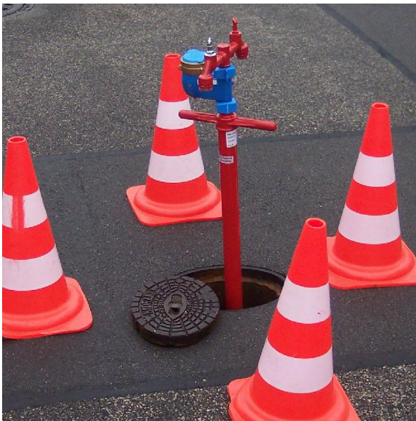
Bild 1. Standrohr mit Zähler für Unterflurhydranten
