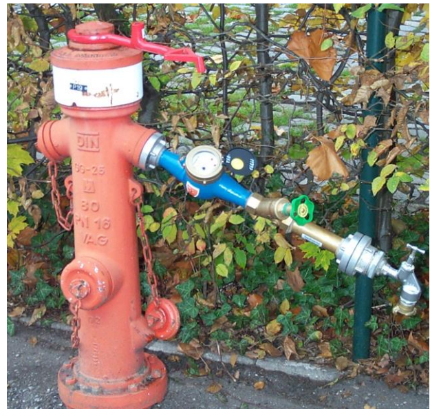
Bild 2. Hydrantenzähler für Oberflurhydranten
